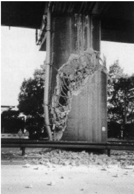
Figuur 1: Brugpijler die bij de aardbeving in 1995 bij Kobe is kapot gegaan
